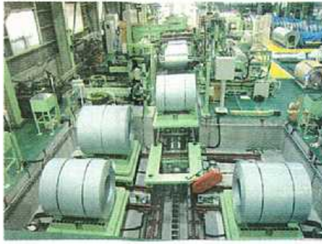
コイル台車4台も新設 （大型スリッターの入り側）
